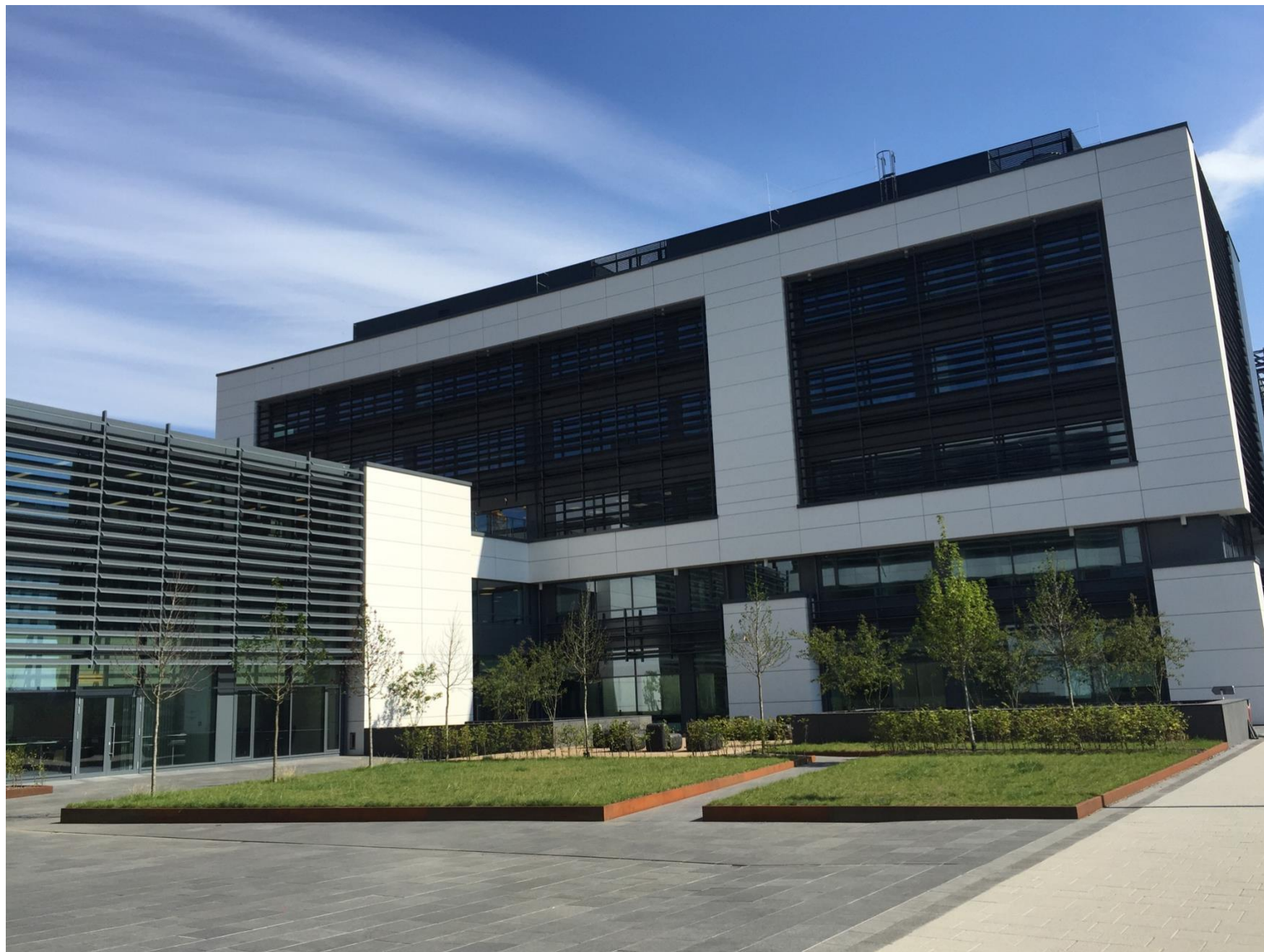
Entrée du bâtiment BT2 sans la sculpture – Vue de côté
