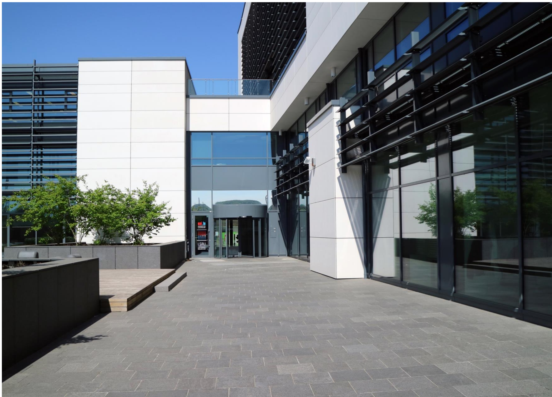
Entrée du bâtiment Biotech 2 (BT2) – Vue de face
